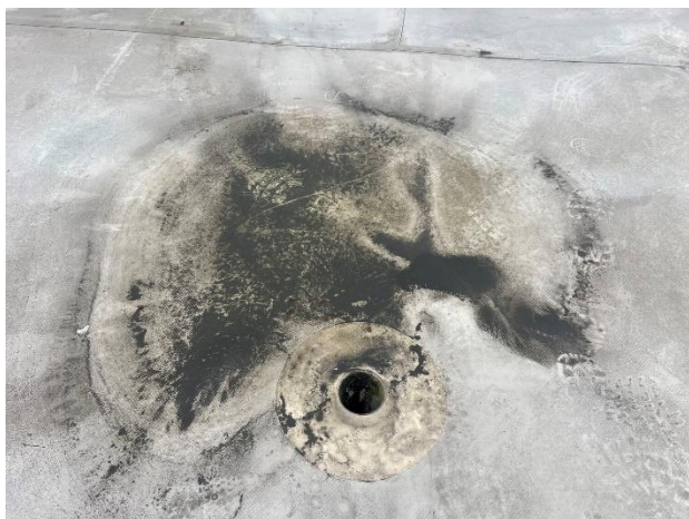
Obr. /5/ Střešní vpust'
