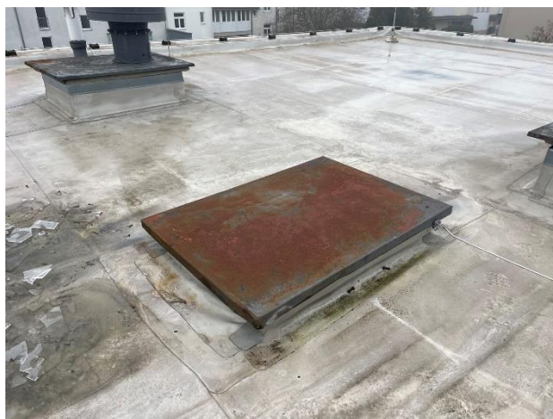
Obr. /11/ Střešní výlez
