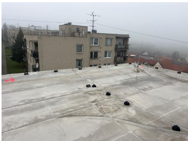
Obr. /19/ Uvolněná kotvící lišta
