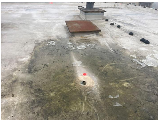
Obr. /7/ Střešní vpust'
