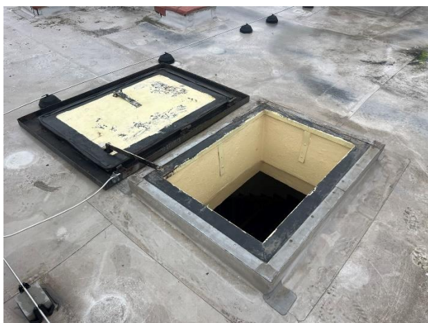
Obr. /12/ Střešní výlez
