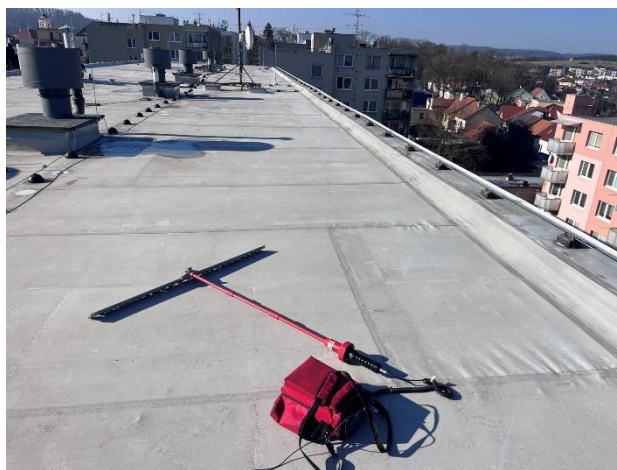
Obr. /4/ Pohled na střešní plášť
