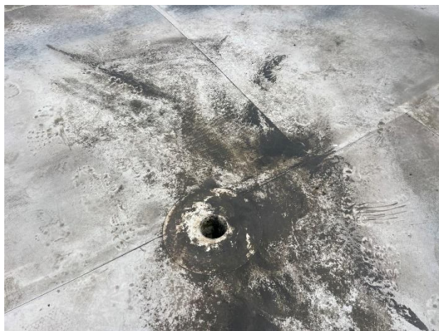
Obr. /6/ Střešní vpust'
