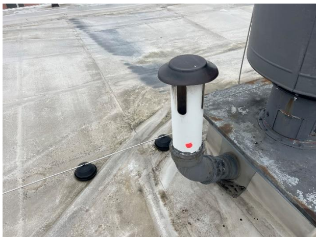
Obr. /25/ Degradace pojistného tmelu (prostupy)
