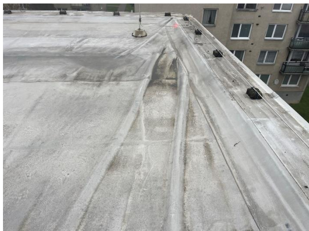
Obr. /20/ Uvolněná kotvící lišta
