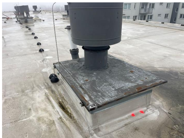
Obr. /14/ Separace svárových spojů
