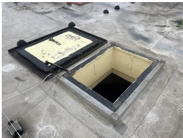
Obr. /32/ Uvolněný poklop výlezu
