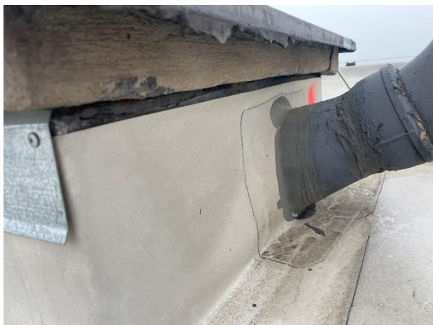
Obr. /31/ Opracování zakončovacího detailu
